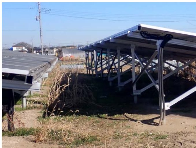
狭隘箇所での施工
