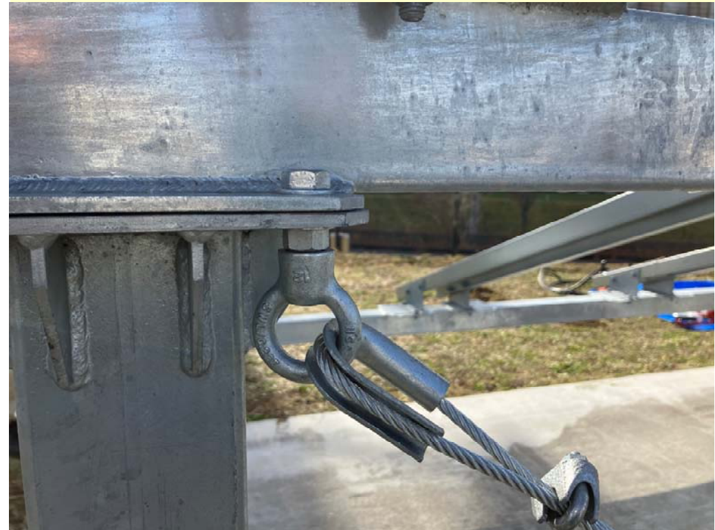
接続性の検証 (既設ボルトにアイナットを接続)
