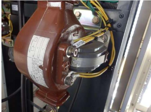
既設の受電盤CT 2次側をRPR専用配線にて分流 (RPR単体の特性試験で気づかず)
