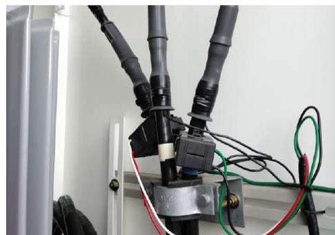
メーカーが不可とする高圧ケーブルに低圧用電流センサーを取り付け
