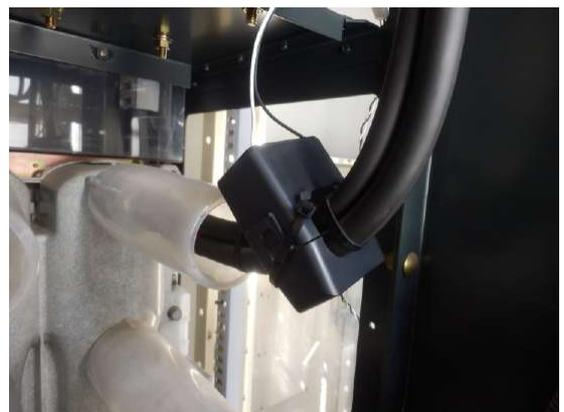
低圧用電流センサーを高圧電線に
