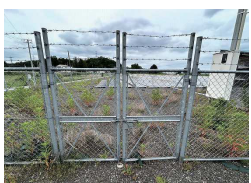
しっかりしたフェンスと扉
