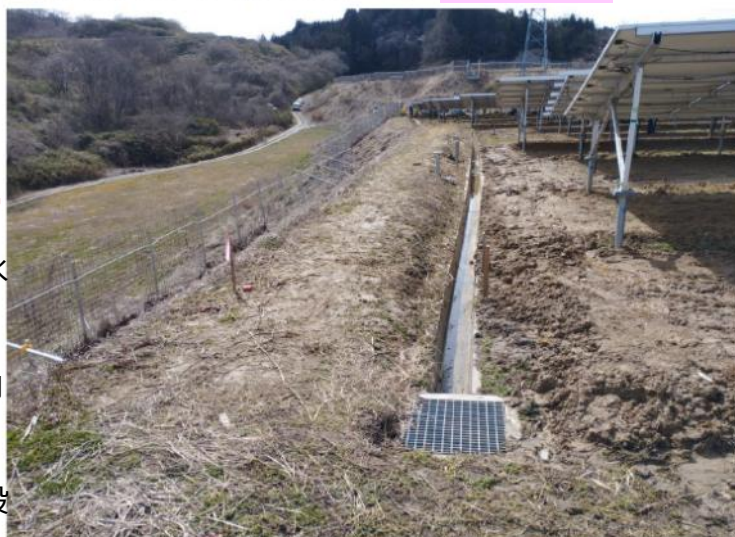
②既設南北U字溝改修工事
